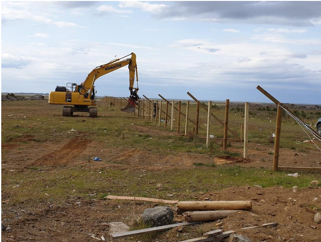
Mynd 7.5. Unnið við uppsetningu foggirðingar í Fíflholtum sumarið 2019. (Ljósmynd. Stefán Gíslason)
