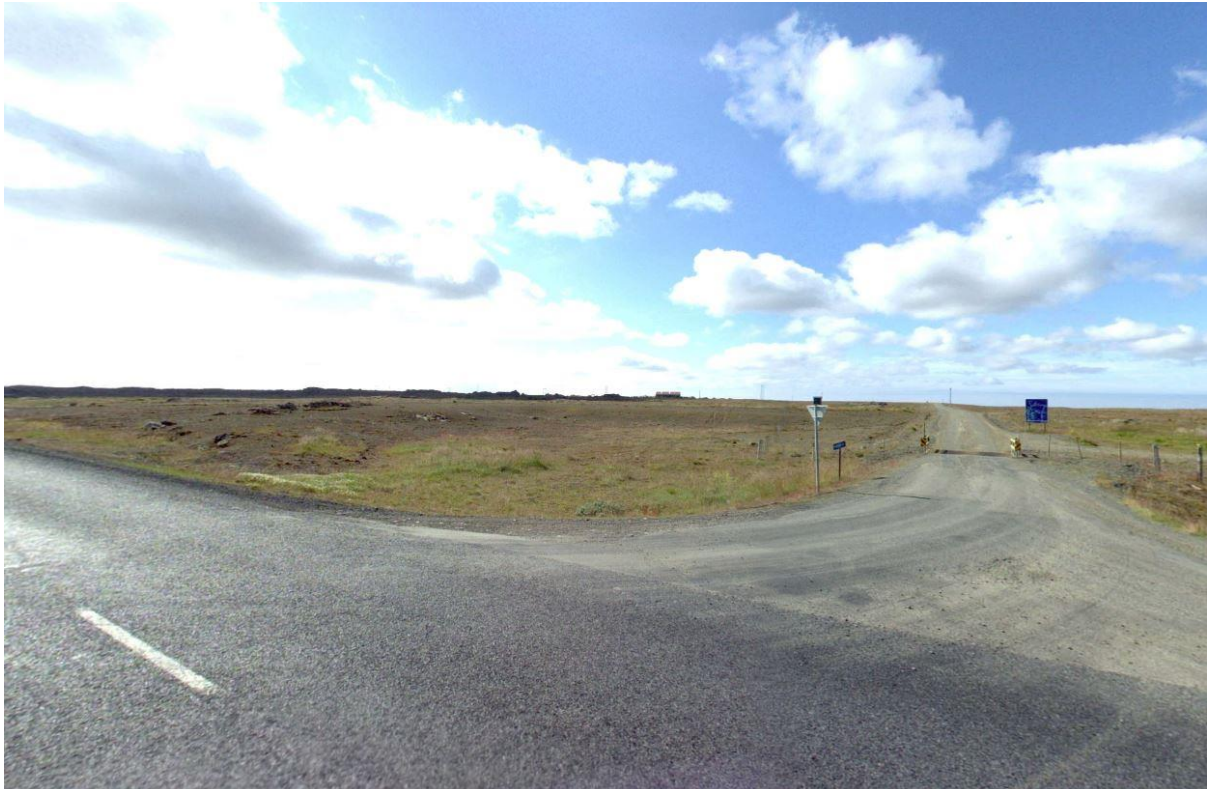
Mynd 7.9 Horft í átt að urðunarstaðnum frá gatnamótum Snæfellsnesvegur (nr. 54) og Hraunhreppsvegur (nr. 540) (skjáskot af ja.is).
