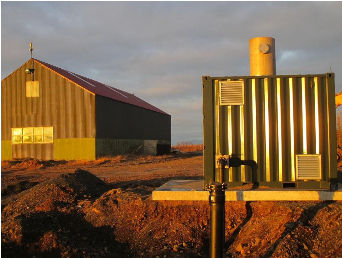
Mynd 7.6. Gasbrennslukyndill í Fíflholtum 26. nóvember 2018. (Ljós. Stefán Gíslason).
